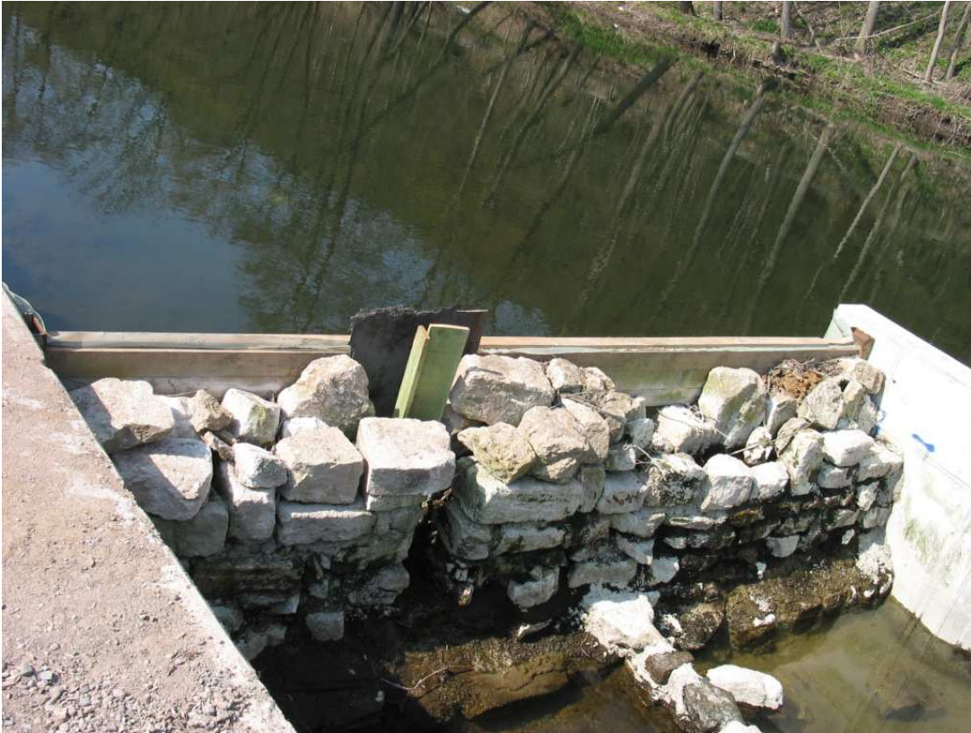
Kompletter Verbau des oberen Zulaufes der Fischtreppe mit Folie und Holz
