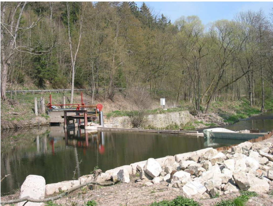
Wasserspiegel im Wehrbecken unter der Wehrkante, Schieber zum Turbinenkanal komplett geöffnet
