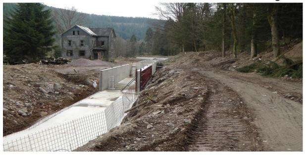
An der Roten Mühle bei Mellenbach-Glasbach wird ein Kleinwasserkraftwerk errichtet, für dessen Betrieb ein Teil des Schwarza-Wassers in einem neuen Graben herangeführt wird. Naturschützer kritisieren den Bau als erheblichen Eingriff in eines der wenigen wirklich naturnahen Thüringer Gewässer. Foto: VANT
