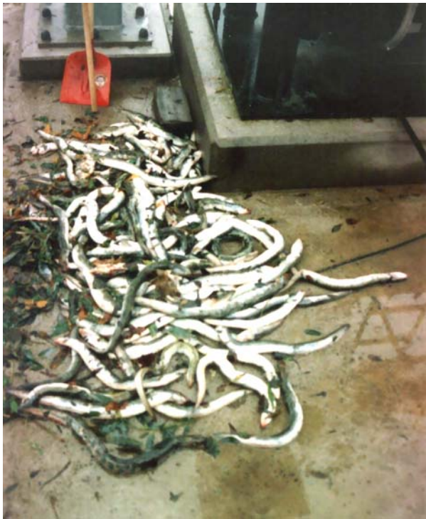
Abb. 3: 96 kg Blankaale = 88 Stück wurden in einer Nacht am Rechen einer Wasserkraftanlage der Lahn vom Rechenreiniger zerdrückt; Photo: Klein
